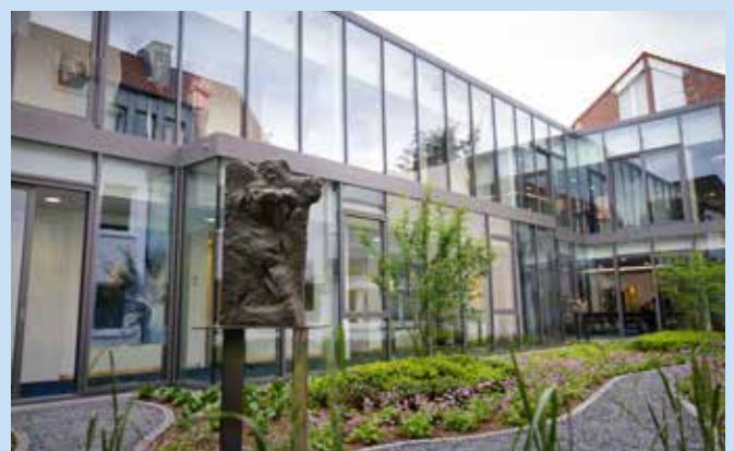
Der Innenhof des neuen Praxiszentrums.
