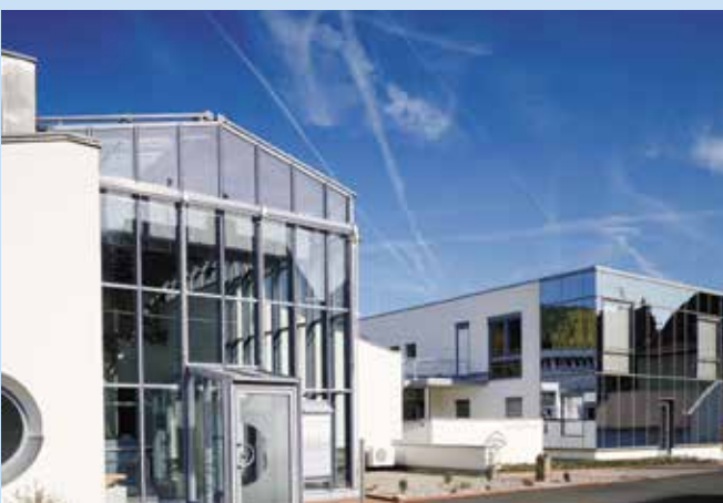
Die Augenklinik Lohr vereint 3 Einrichtungen unter einem Dach.
